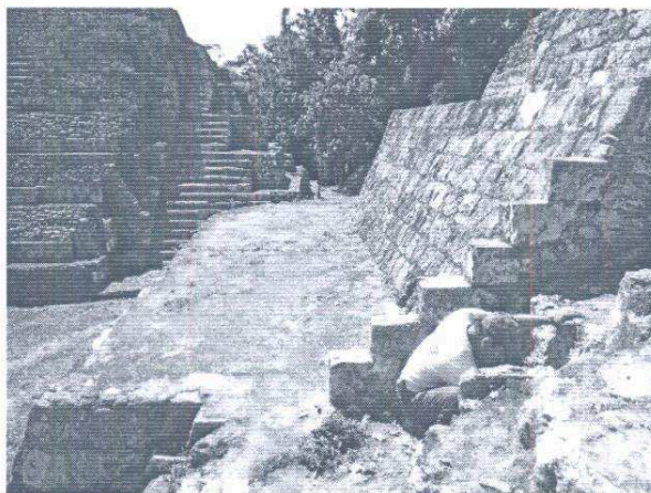
Foto 3. Edificio 144 durante los trabajos de limpieza de maleza
